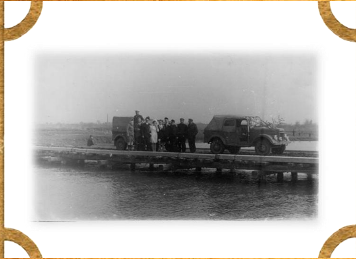
Мост через реку Оскол в районе ул. Кольцова, п. Чернянка
