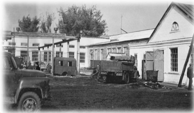
Ремонтно-техническая мастерская районного объединения «Сельхозтехника», 1958 г.
