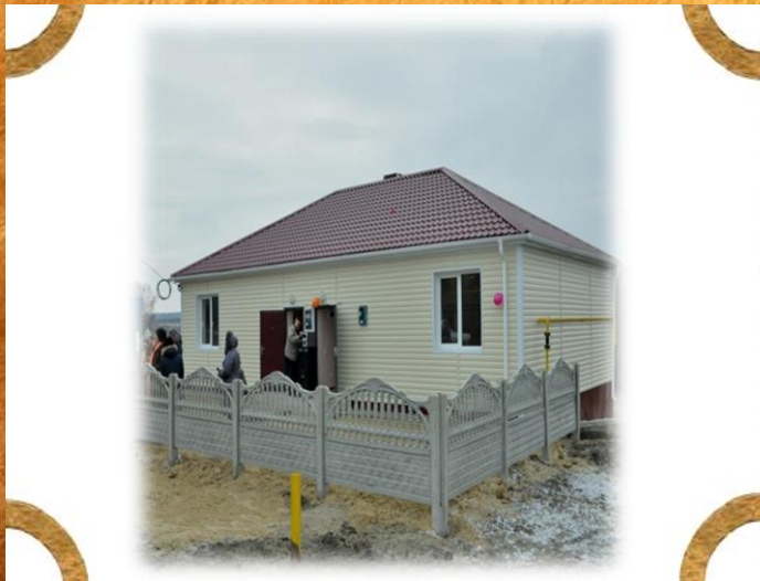
Ежегодно в Чернянском районе идет полным ходом строительство жилых домов для детей-сирот.
