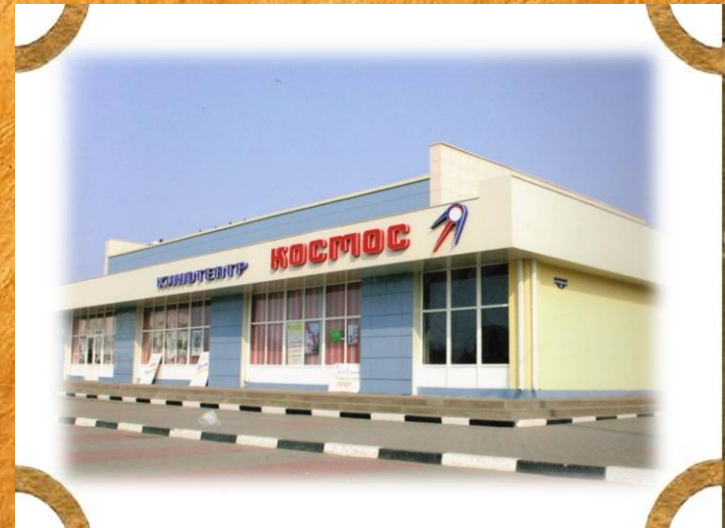
Кинотеатр «Космос» после реконструкции. В наши дни, в этом здании расположен Центр молодежных инициатив, который торжественно открыт 1 сентября 2016 г.
