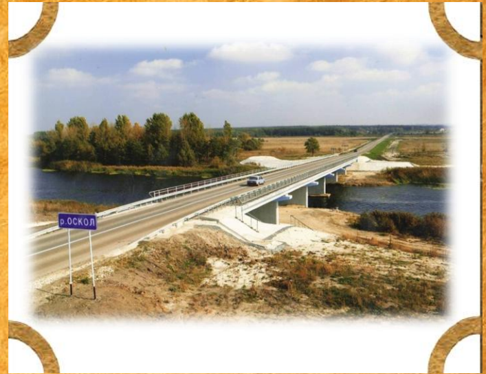
Мост на объездной дороге в Чернянке
