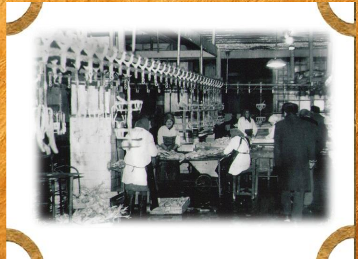
Чернянский мясокомбинат, 1980-е г.г. Первым зданием был яйцесклад, построенный в 1929 г.
