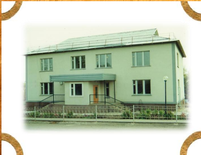
Здание основной общеобразовательной школы в селе Большое Чернянского р-на, введено в эксплуатацию в 1998 г.
